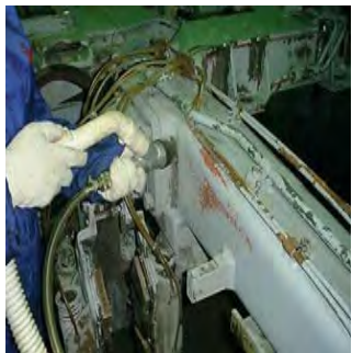
台車溶接部塗装落し
